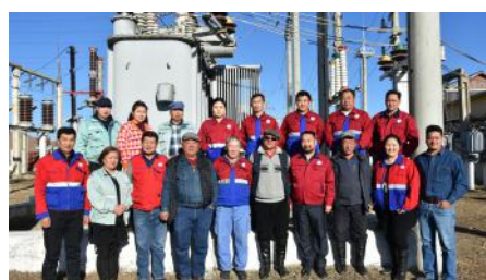
Зүүнхараа дэд станц
