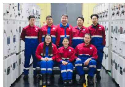
Хүхрээ дэд станц
